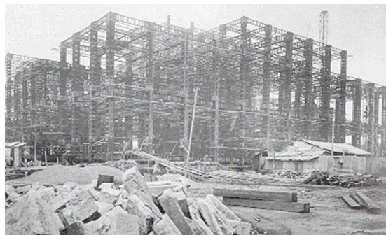
震災後の再建工事の様子
