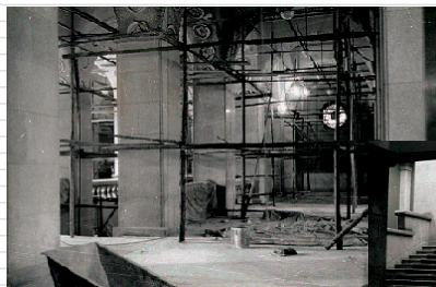
改修作業風景（3階）
