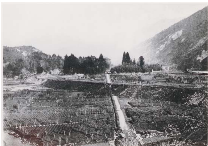
写真1. 水鳥付近の根尾谷断層の断層崖
