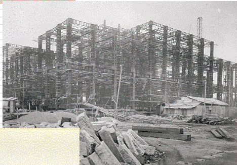
図書館工事風景
